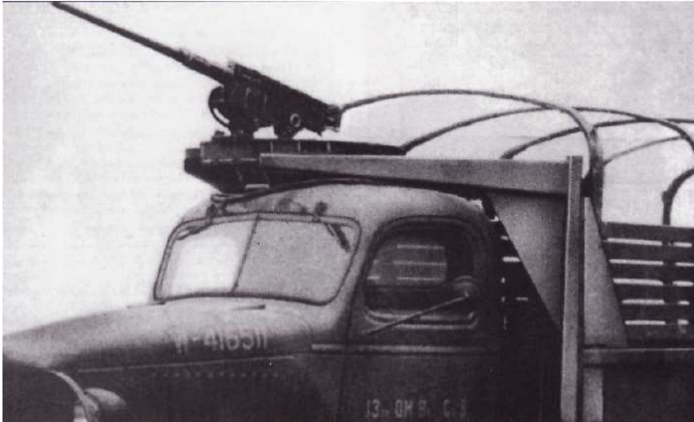
Detailní pohled na upevnění otočné lafety pro kulomet M2HB na střeše CCKW 353
